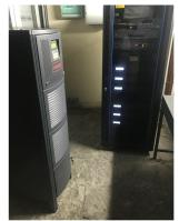
Fra l'UPS e il sistema RTI c'è una comunicazione bidirezionale quindi è sempre possibile sapere quanto è la carica dell'UPS e, in mancanza di corrente, tramite un ingresso programmato sul sistema RTI e con una buona distribuzione dei carichi, è possibile far funzionare l'intero impianto per circa due ore. Cosa succede dopo? Lo step successivo è stato quello di dare spazio una logica prioritaria.
